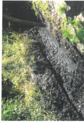
Ecoulement de substances polluantes dans un fossé
