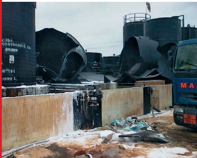
▲ Erreur de dépotage de chlorite de sodium dans un bac de chlorure ferrique.
